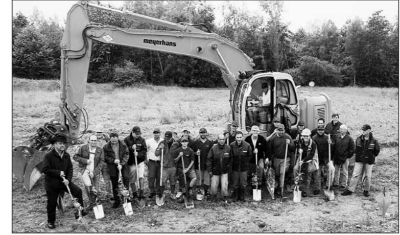
Mit drei Vollgeschossen mit einer Attikawohnung und einer Lagerhalle auf einer Fläche von 2500 Quadratmetern verlagern die beiden Petralli-Betriebe, Gartenbau und Hauswartungen, ihren Sitz auf Ende Jahr vom Leh 15 in den Löffelchratte 1 in Stachen. Damit werden für rund 30 Mitarbeiter optimale Verhältnisse mit guten, sicheren und modernen Arbeitsplätzen für eine aussichtsreiche Zukunft geschaffen. Was am Freitag, 15. Juni 1984 – damals tauschte der stellvertretende St.Galler SBV-Direktor Reto Petralli seinen Anzug mit weissem Hemd und Krawatte gegen währschafte Handwerkerkleidung... – mit Schaufel, Pickel und Karette in einem Mietobjekt im Niederfeld bescheiden begann und im Leh seine Fortsetzung fand, endet vorläufig in einem funktionell und architektonisch überzeugenden 3-Mio.-Franken-Objekt. Wenn immer möglich werden die Arbeiten – wie bei Reto Petralli üblich – an Betriebe in der Region vergeben. – Unser Bild zeigt den Spatenstich der Petralli-Belegschaft im Löffelchratte 1 in Stachen.
