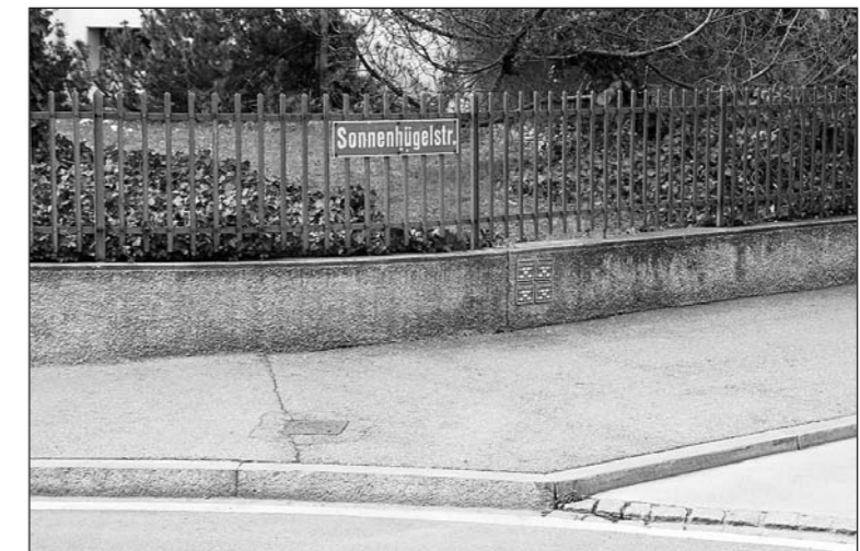
«Steine des Anstosses» waren die Randabschlüsse bei der Sanierung der zweiten Etappe der Sonnenhügelstrasse im Jahr 2001.
