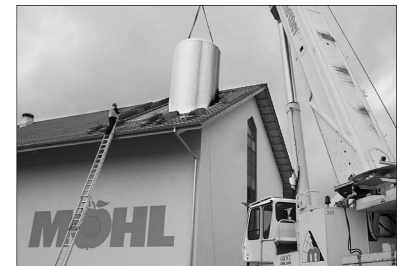
Gigantisch! Insgesamt acht weitere Chromstahl tanks mit einem Fassungsvermögen von 750 000 Litern wurden im 2005 erbauten Tanklager «versenkt». Damit beläuft sich die Lagerkapazität der Mosterei Möhl auf 1,85 Mio. Liter Konzentrat, was einer Menge von 14 Mio. Liter Saft entspricht.
