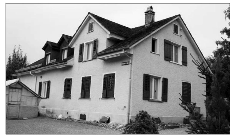
540 000 Franken kostet die Sanierung des Friedhofgärtnerhauses in Arbon.
