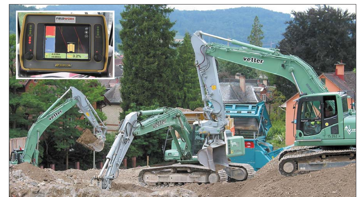
GPS-gesteuerte (kleines Bild) Bagger auf der Grossbaustelle Brauerei Haldengut in Winterthur.
