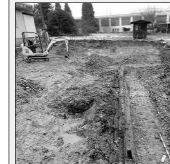
Die vor Weihnachten freigelegte Holzkonstruktion an der Gerbergasse in der Arboner Altstadt.
