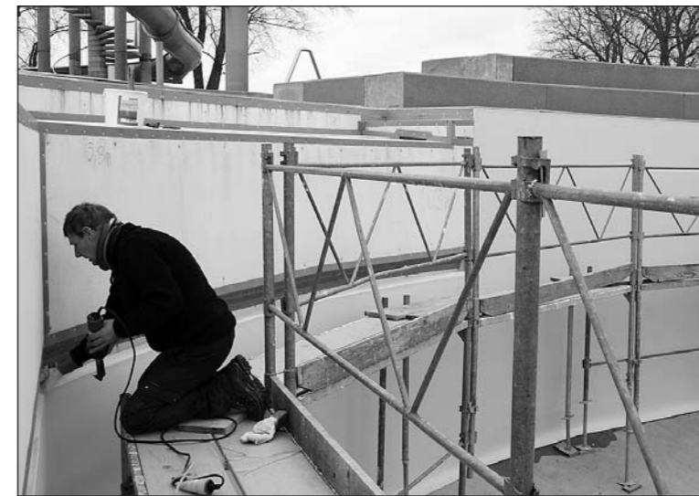
An kunststoffbeschichteten Blechen wird die 1,5 Millimeter dünne Folie mit Heissluft thermisch (beulen- und faltenfrei) angeschweisst.
