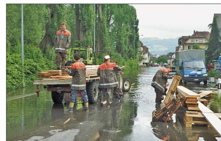
Feuerwehr beim Bau von Notstegen an der Steinacher Hauptstrasse.
