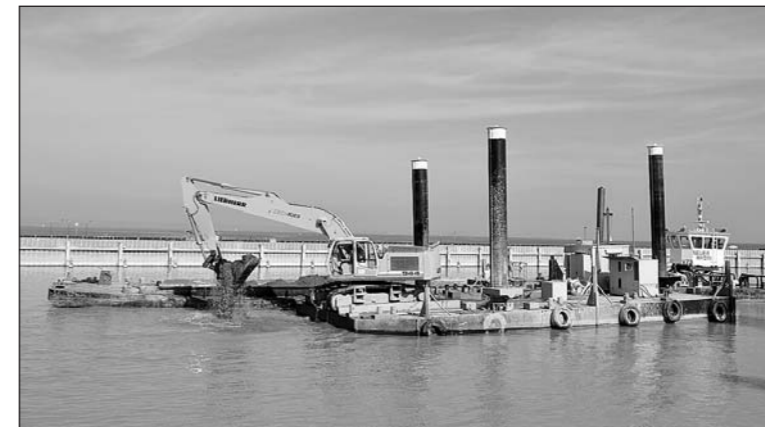
Der 40-Tonnen-Bagger auf dem Ponton verschiebt sich mit eigenem Löffel.
