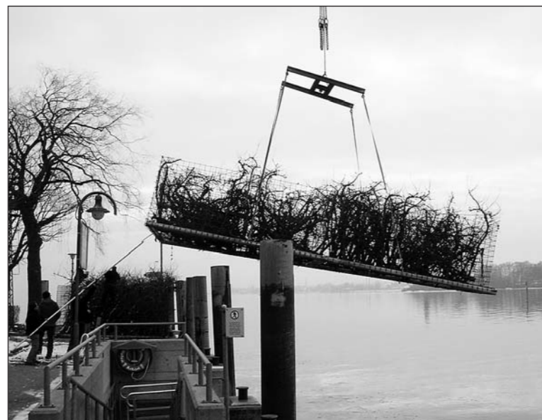
Der Bau und die Erstellung von Fischreisern ist eine von wenigen Massnahmen, die in stillen Gewässern getroffen werden können, um den Lebensraum für Fische aufzuwerten.
