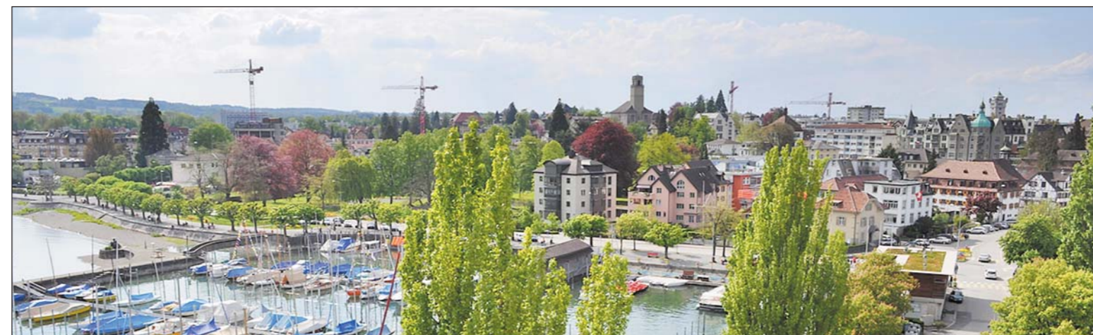
Baustelle Arbon – Baukräne überragen die Silhouette der Stadt der weiten Horizonte...
