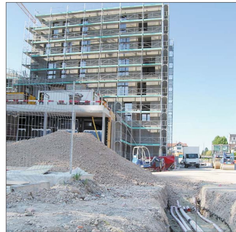
Das Projekt «Rosengarten» ist ein gelungenes Beispiel für die konzernübergreifende Zusammenarbeit bei Implenja. Die interdisziplinäre Zusammenarbeit sorgt für ein Bauwerk mit hoher Wirtschaftlich- und Nachhaltigkeit.
