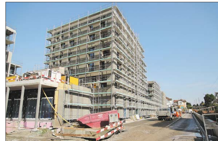
Für das «Rosengarten»-Bauvolumen von rund 100 000 Kubikmetern werden zwischen 65 und 70 Mio. Franken investiert.
