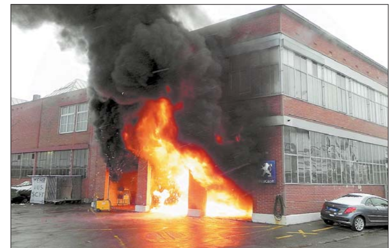
Brand im Autohaus Arbon – die Stützpunktfeuerwehr Arbon rückte mit 48 Leuten aus und brachte das Feuer, das sich von einem brennenden Auto auf die Werkstatt ausgebreitet hatte, rasch unter Kontrolle.
