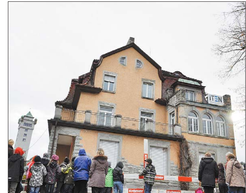
Der «Breitehof» in Arbon – um 8,1 Meter gegen Norden und 3,9 Meter gegen Westen verschoben, um der NLK Platz zu machen.
