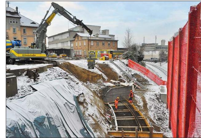
Planmässig erstellt wurden bereits die Schutzgerüste im Bereich des Stahelplatzes gegen die Gleisanlagen. Die Voraussetzungen für den Bau des eigentlichen Unterführungsbauwerkes sind somit geschaffen.
