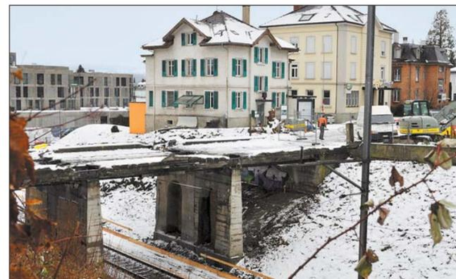
Das Ende der Rebenstrasse-Brücke neben dem Baubüro – mit einem Autokran werden die Brückenteile von Sonntag auf Montag entfernt.
