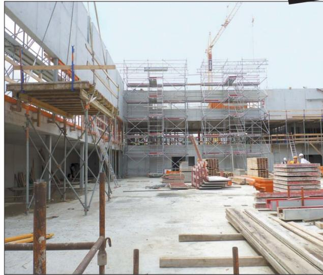
Nun sind Volumen und Grösse der neuen Sporthalle spürbar. Das Bild wurde vom zukünftigen Hallenboden aus, mit Blick Richtung Foyer und darüberliegendem Mehrweckraum, aufgenommen. Die Betonierarbeiten werden noch bis zu den Sommerferien dauern. Gegen Ende Juni werden die Dachträger versetzt und anschliessend das Dach gedeckt. Die Innenausbauarbeiten starten nach den Sommerferien.
