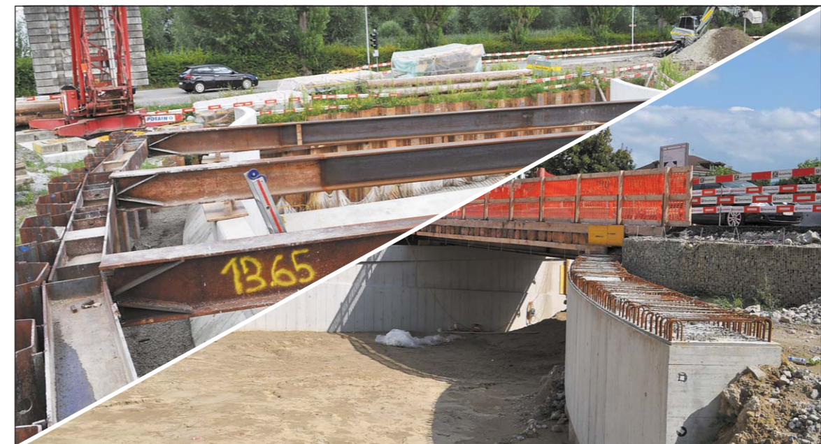
In Steinach haben die Strassenarbeiten beim Unterführungsbauwerk im Bereich der Hauptstrasse begonnen... und beim Arboner Stahelplatz wurden die Strassenbauarbeiten an der Romanshonerstrasse in Angriff genommen.
