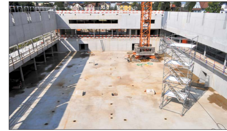
Falsch geplant – der gewölbte Betonboden in der Arboner Sporthalle muss herausgerissen, neu gegossen und doppelt so stark verankert werden.
