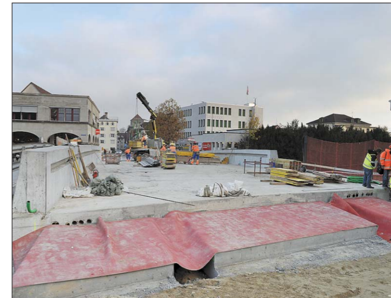
Mit 13,12 Mio. Franken der grösste Brocken für Arbon: die «Neue Linienführung Kantonsstrasse» (NLK), die im Oktober 2013 eingeweiht werden soll.
