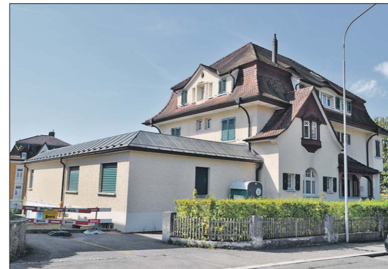
Ende September nach umfassendem Um- und Ausbau wieder bezugs- bereit – das Bürgerheim «Bergfrieden» an der Römerstrasse 31 in Arbon.
