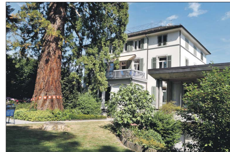
Voraussichtlich Mitte 2016 bezugsbereit – das erweiterte neue Alters- und Pflegeheim «Quisisana» an der Berglistrasse 13+15 in Arbon.
