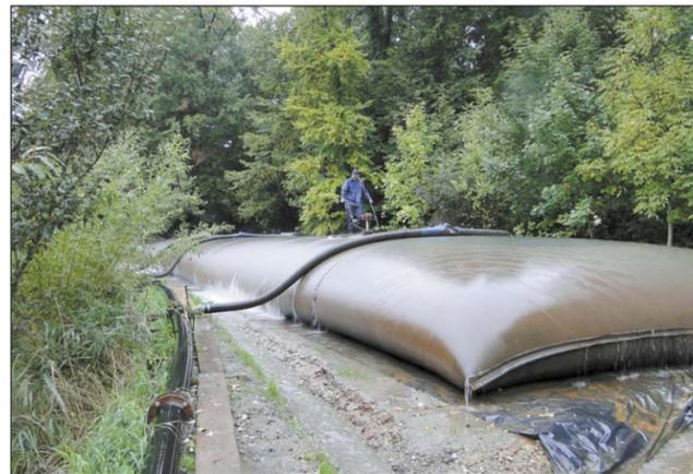
Weiher Arbon: Entwässerung mit den Geotubes.
