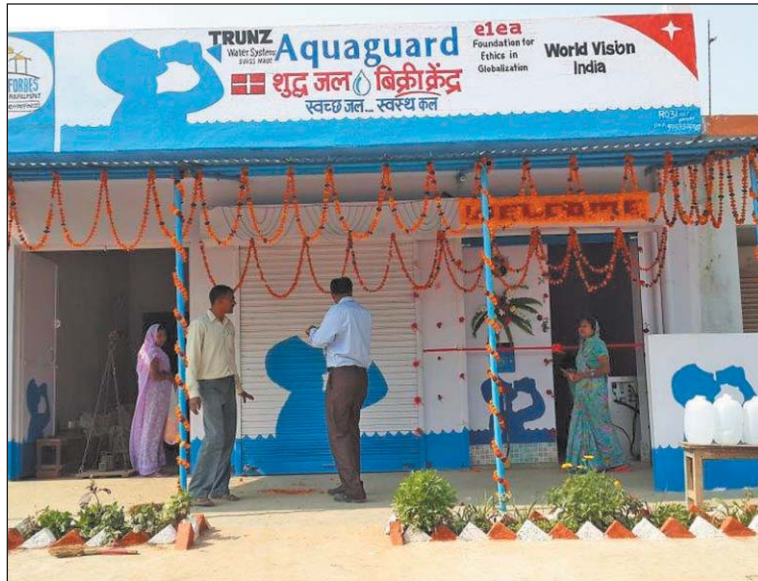
Sauberes Trinkwasser und Elektrizität zu günstigen Preisen – mit «Nexus-Center» bietet Trunz Water Systems ein innovatives Geschäftskonzept.
