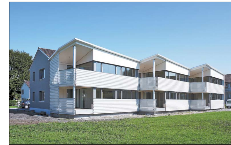
Sukzessive werden die sechs Einheiten mit je sechs Wohnungen umgebaut. Die «Stägehüsl» an der Landquartstrasse erfreuen sich grosser Beliebtheit
