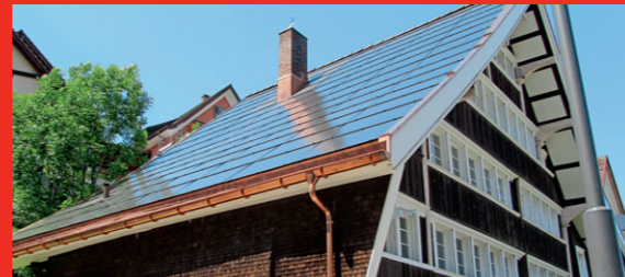
Mehrfamilienhaus Speicher | Leistung: 15,51 kWp
