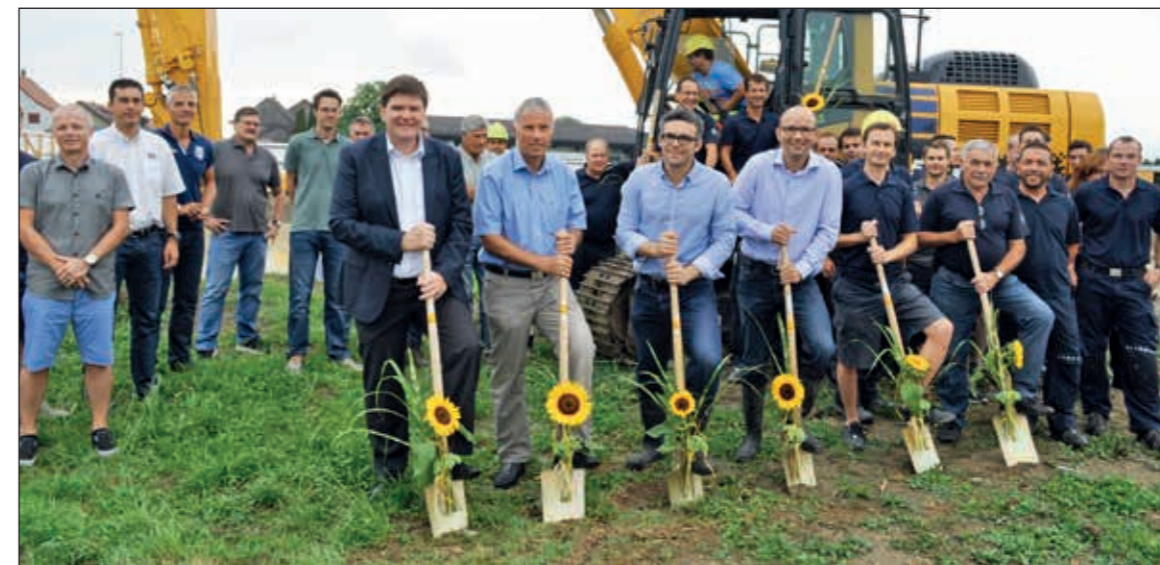
Spatenstich im Beisein der Eugster-Belegschaft und Vertretern der Baufirmen: (vorne von links) Gewerbeverband-Präsident Hansjörg Brunner, Roggwils Gemeindepräsident Gallus Hasler, Eugster-Geschäftsführer Daniel Eugster, Architekt Stefan Keller, Eugster-Teamplaner Patric Eberhard und Firmengründer Heinz Eugster.
