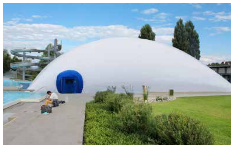
Das 25-Meter-Becken im Seebad Romanshorn wird mit einer Traglufthalle überdacht. Dieses Projekt ist für den Oberthurgau bedeutend – und es hat Strahlkraft über die Region hinaus. Die Finanzierung steht nun auf einem soliden Fundament.
