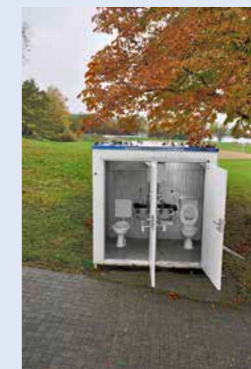
Der alte WC-Container beim Seeparksaal wird ersetzt.
