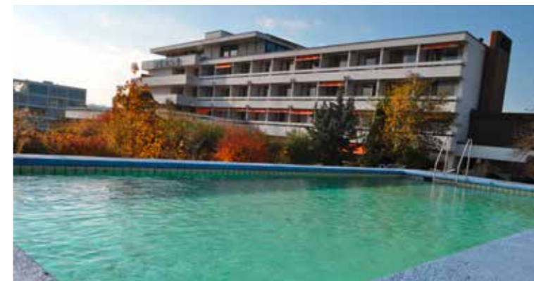
Das Obergutachten besagt: Das Hotel «Metropol» ist in seinen ursprünglichen Teilen schutzwürdig. Dies gilt jedoch nicht für die nachträglich erstellten Anbauten.
