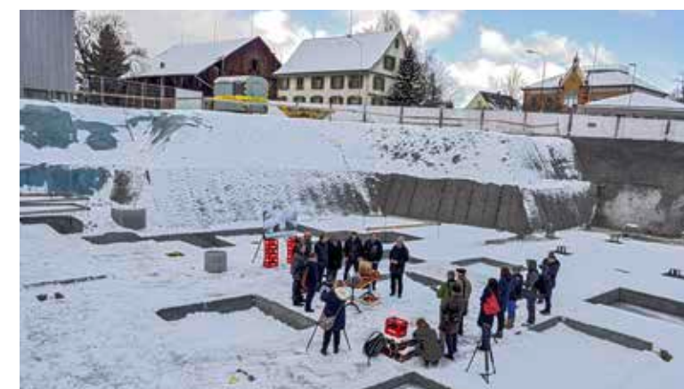
Die imposante Baugrube an der St. Gallerstrasse in Stachen: Hier entsteht das Möhl-Besucherzentrum, das im September 2018 eröffnet werden soll.
