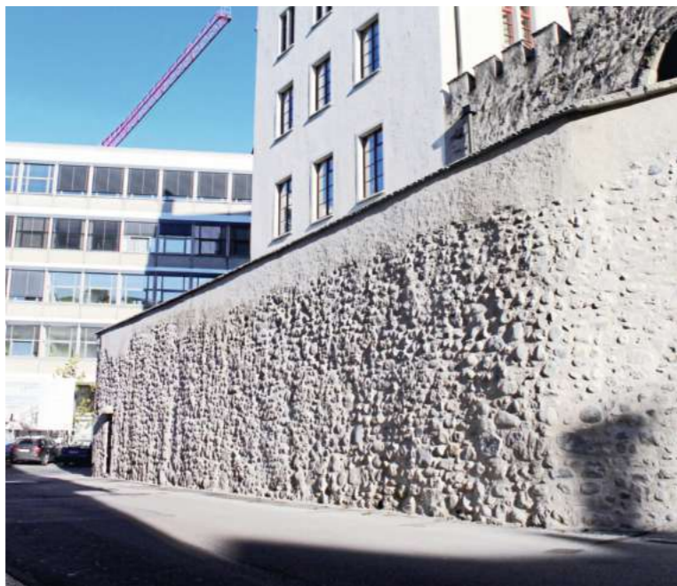
Renovierter Mauerabschnitt entlang der Schlossgasse.
