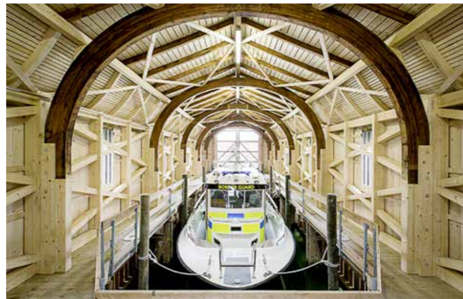
Renoviertes Bootshaus am Arboner Hafen – ein Referenzobjekt der Fecker Holzbau AG.
