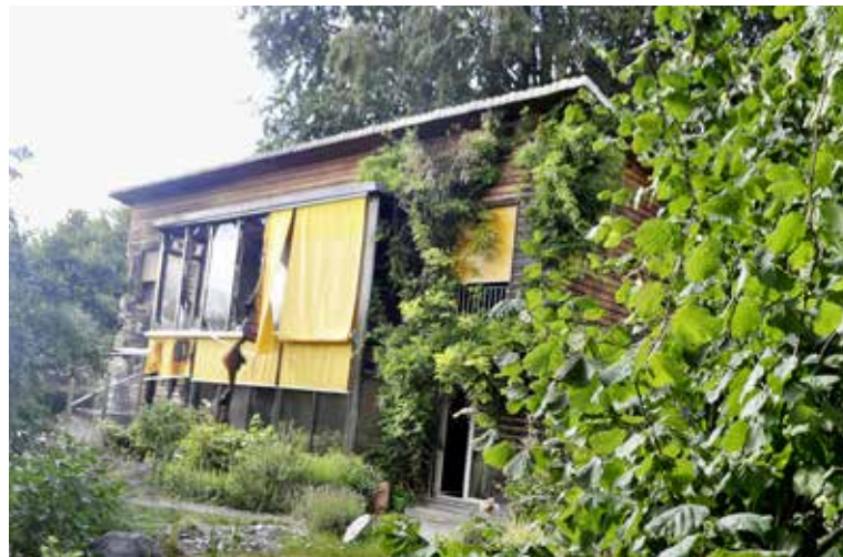
Das leerstehende und nun zerstörte Holzhaus am Lavendelweg 11, direkt neben dem Kindergarten Thomas-Bornhauserstrasse, in Arbon nach dem Brand.
