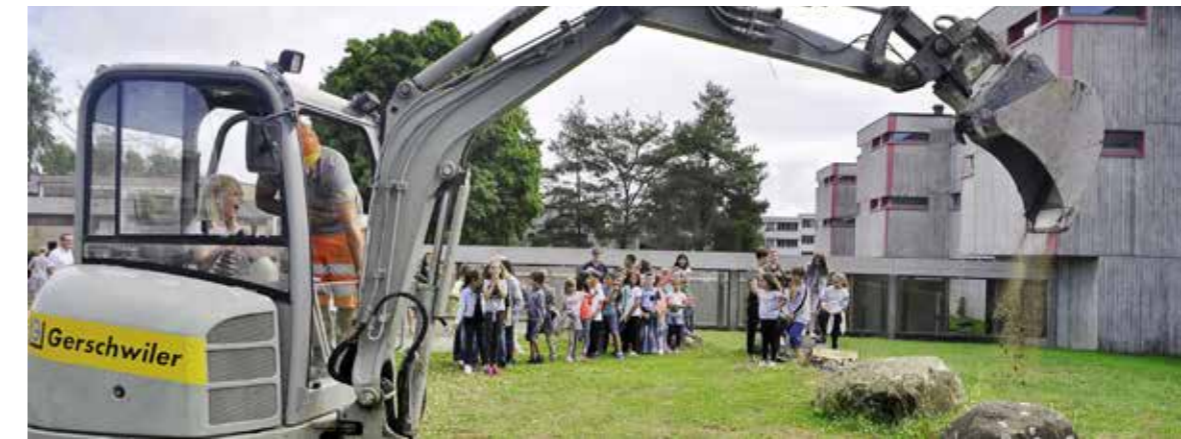
Mit dem Bagger dürfen die Schulkinder der Klassen Hug und Frieden ein Stück Pausenwiese abtragen für den Neubau.
