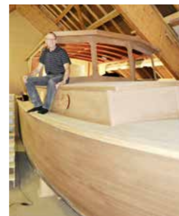
Im November 2017 ist der Rohbau der Motoryacht aus Holz vollendet.
