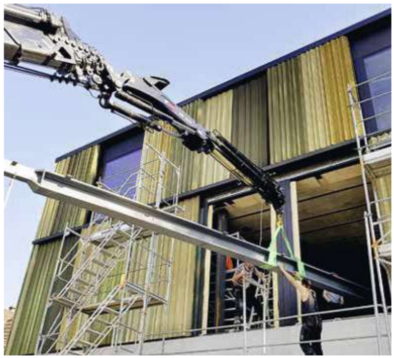
Für die Verstärkung der Saaldecke werden Stahlträger eingehoben.
