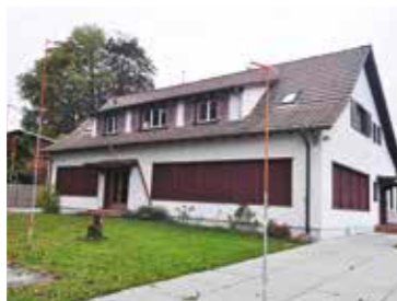
Abbruch und Neubau verzögert sich: Kindergarten Thomas-Bornhauserstr.
