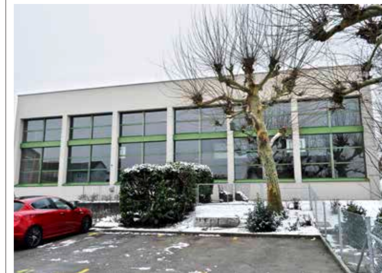
Die bestehende, im Jahr 1976 gebaute Steinacher Turnhalle: Sanierungsbedürftig und nicht mehr den Normen des Bundesamtes für Sport entsprechend.
