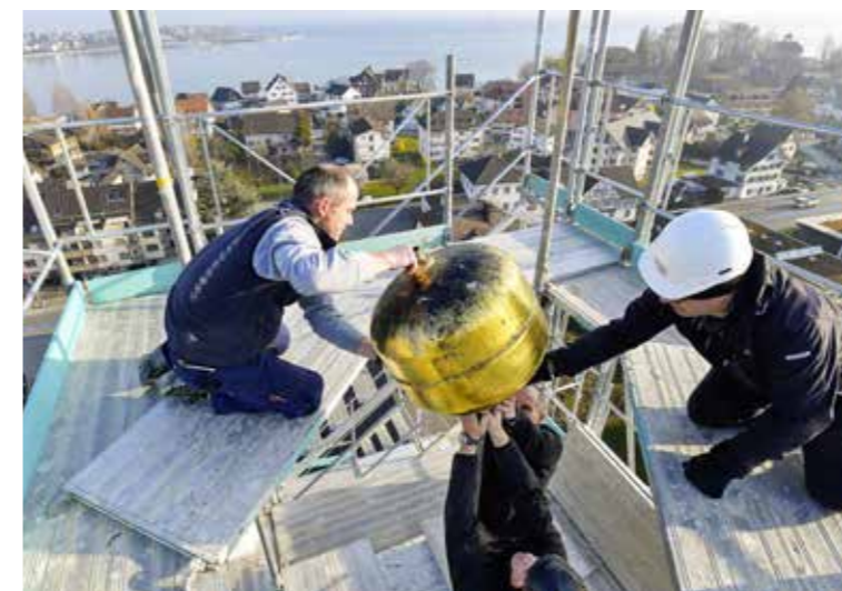
Handwerker demontieren in luftiger Höhe die goldene Kugel vom Kirchturm.
