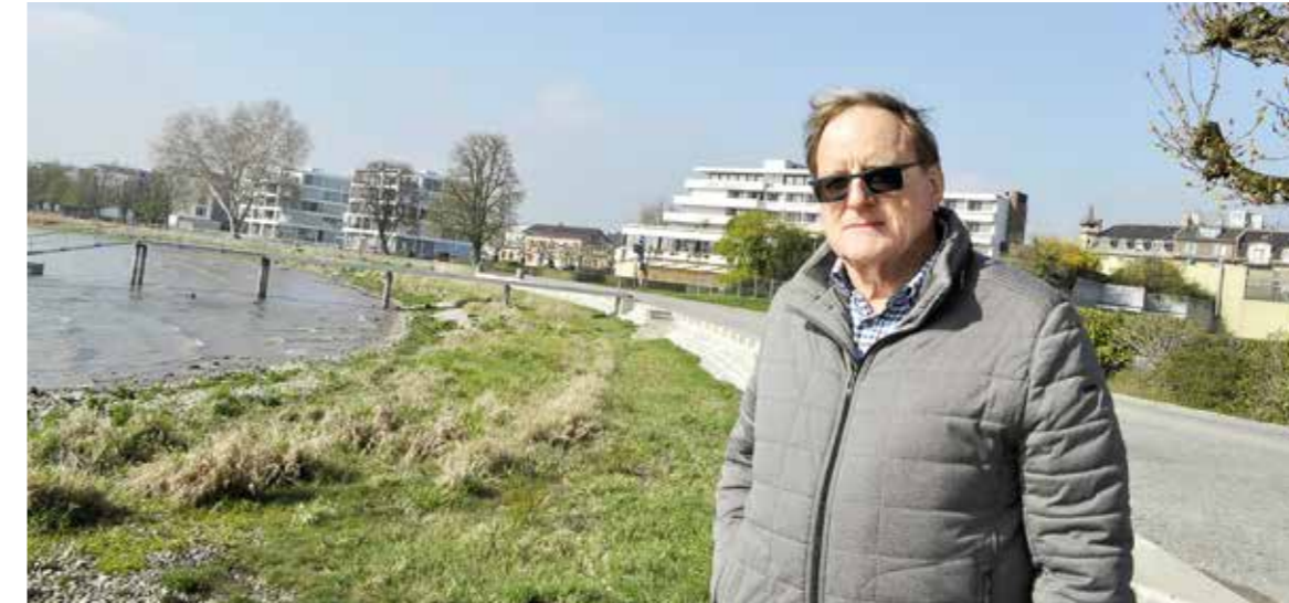
Kurt Sonderegger vor dem «Metropol». Die gesamte Uferpartie vom «Haus am See» (weisses Gebäude links des «Metropol») bis zum Seemoosriet ist im Bundesinventar der schützenswerten Ortsbilder der Schweiz (ISOS) erfasst.
