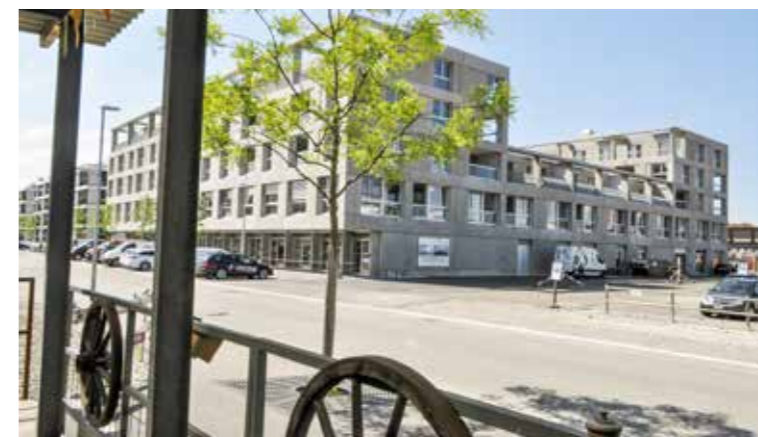
Das «Casa Giesserei» von aussen. Es gehört den «Zürcher Baufreunden» und wird betrieben von «Sensato», einer Familien-AG von Guido Reber aus Bern.
