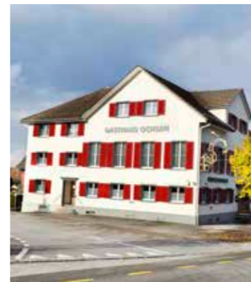
Das Gasthaus Ochsen in Roggwil: Die Verkaufsverhandlungen mit der Gemeinde kommen ins Rollen.
