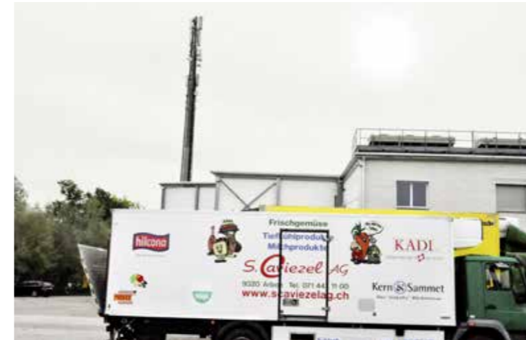
«Swisscom» sendet von ihrer Mobilfunkantenne Schöntal bei der Firma Caviezel seit 9. Dezember mit 5G-Technologie.
