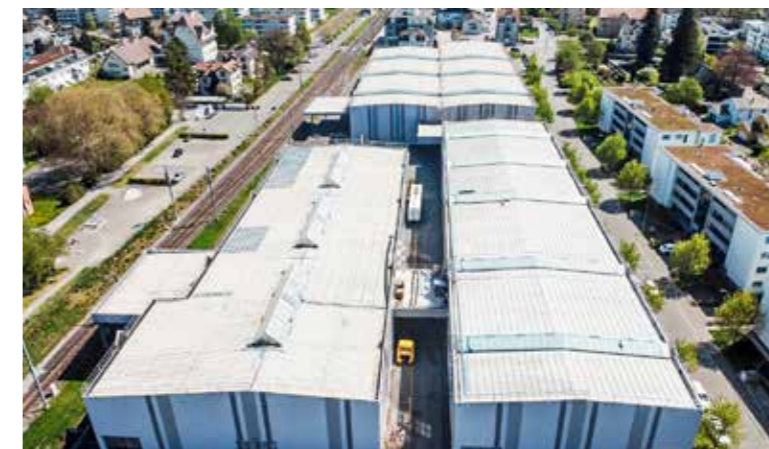
Blick auf die Dächer der Firma Welser in Horn, direkt neben der Bahnlinie (links). Die PV-Module werden in den nächsten Tagen montiert.
