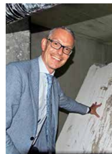
Der Durchstoss: Michael Aebisegger kippt die letzte Trennwand zwischen Alt- und Neubau um.
