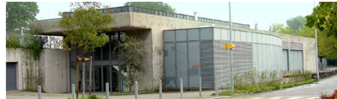
Das Seewasserwerk in Arbon wird in den kommenden drei Jahren umfassend erneuert.
