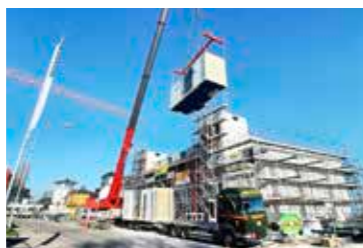
Ein Spezialkran hob die vorgefertigten Zimmer an ihren Platz.
