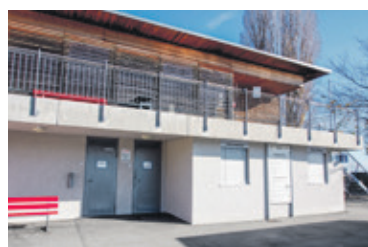
Derzeit geschlossen: Das WC auf dem Arboner Hafendamm.
