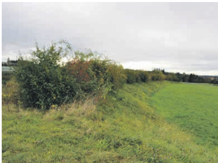
Der Wall wird stellenweise abgetragen und die Bepflanzung entfernt.
