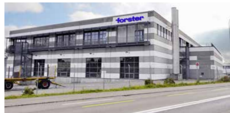
Noch produziert hier die Forster Profilsysteme AG für den Weltmarkt: Industriehalle an der Romanshornstrasse in Frasnacht, im Besitz der Firma Mubea.
