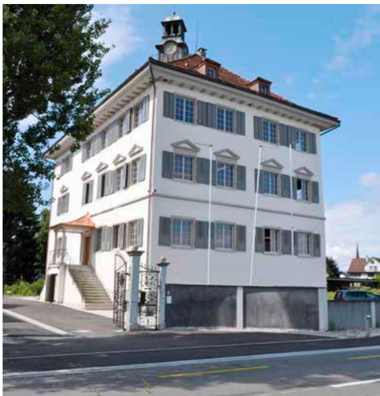
Schloss Horn ist totalsaniert und renoviert – der grösste Eingriff in der 500jährigen Geschichte. Das Gebäude ist an mehrere Unternehmen vermietet.
