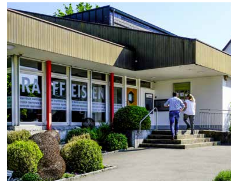
Das Raiffeisengebäude in Roggwil soll einem Neubau weichen.
