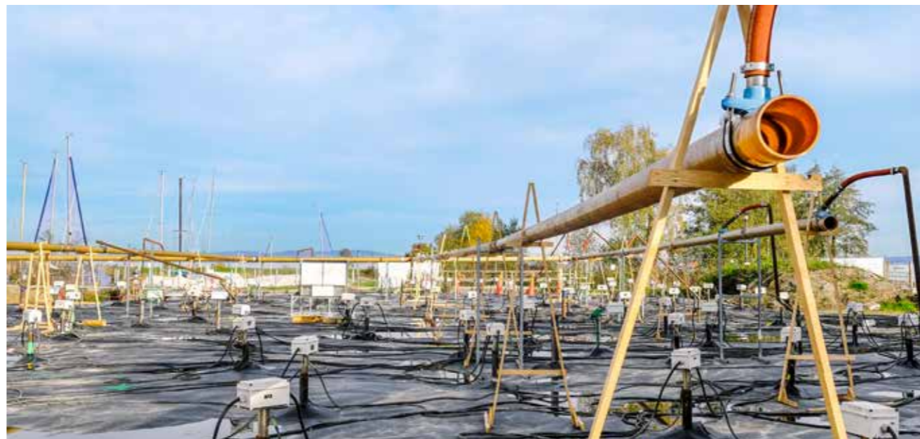
Röhren in der Luft und Elektrosonden fast 20 Meter tief im Boden: So wird das Raduner-Areal von seinen Altlasten befreit.
