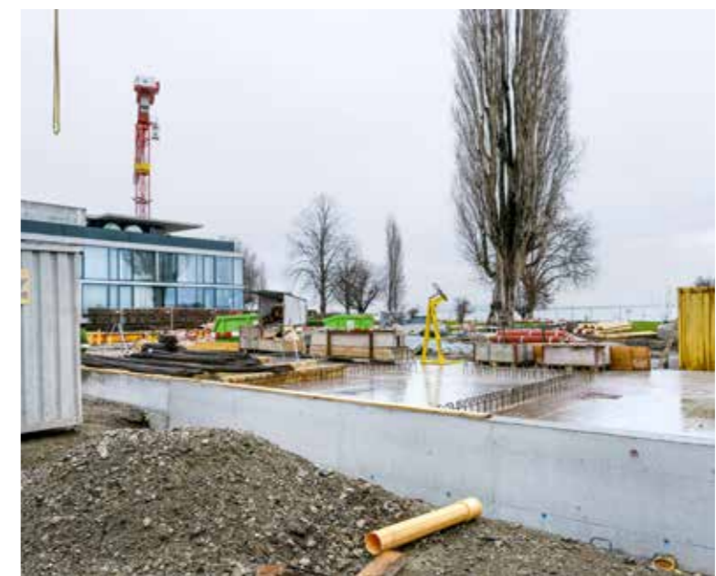
Die Bauarbeiten für den Neubau der Badi Horn sind in vollem Gange. lg
