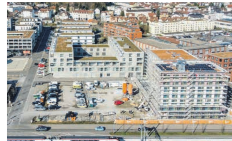
Die heute als Park- und Bauplatz genutzte Fläche zwischen Senevita Giesserei und dem neuen Hotel soll saniert werden.
